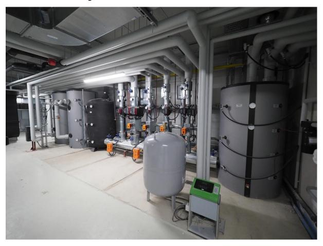
Das Gebäude wird durch einen Kessel und ein BHKW beheizt und mit Strom versorgt. Dadurch erreichen wir den KFW 70 Standard.
